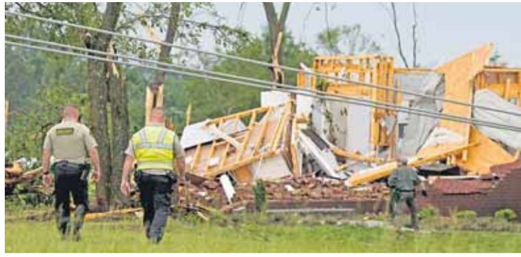
A szél villanyvezetéseket szakított le, fákat döntött ki és lakóépületek semmisített meg (TASR/AP)
